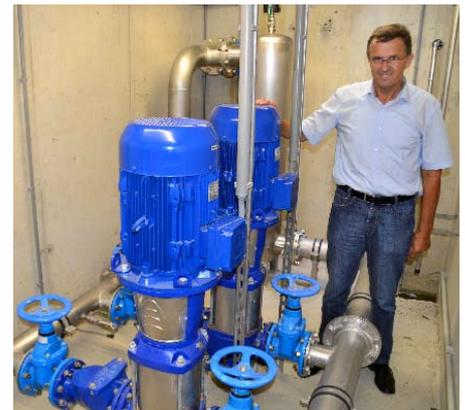
Druckerhöhungspumpen mit je 18,5 kW Nennleistung
