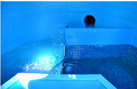
Blick in den Quellsammelschacht, ausgestattet mit Sandfang und Messwehr
