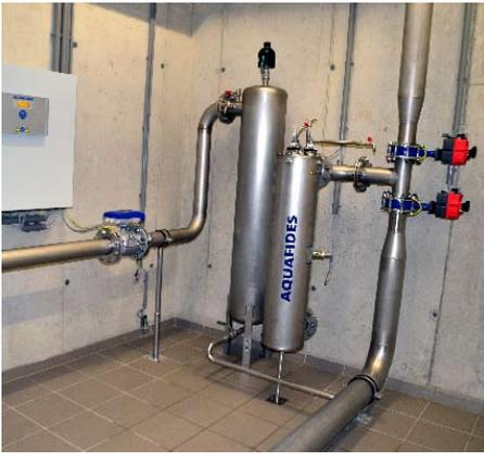
Das von der Druckerhöhungsanlage Schönau hochgepumpte Wasser strömt durch die UV Desinfektionsanlage, bevor es in den Hochbehälter eingeleitet wird.
