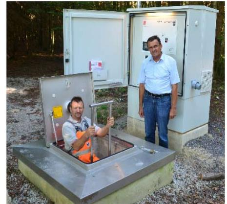
Schalt- und Steuerschrank mit Einstieg in den Pumpenschacht. Die Daten werden zur Zentrale im Bauhof übertragen. Datenaustausch auch zwischen Hochbehälter Aigen und Druckerhöhung Waldtal.
