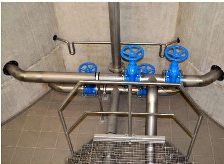
Kellergeschoß im HB Schönau, Entnahme- und Entleerungsleitung aus Edelstahl
