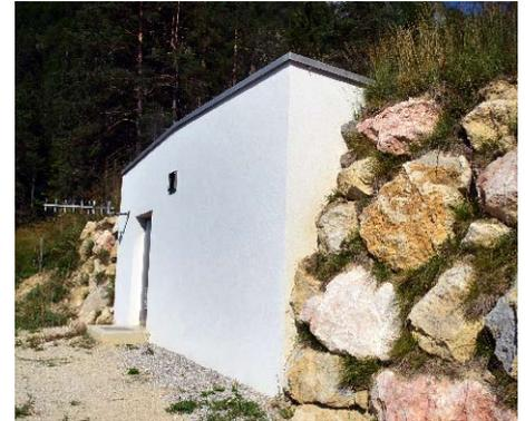
Der Eingangsbereich des erdüberdeckten Hochbehälters Schönau mit einem Gesamtspeichervolumen von 450 m<sup>3</sup>, Höhenlage 703,50 m über Adria = Höhenlage Hochbehälter Eulenstein
